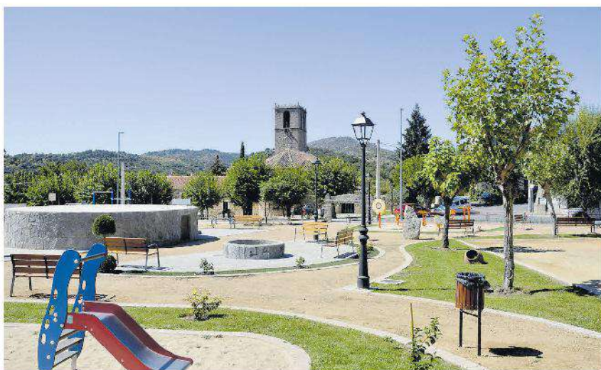
El Ayuntamiento está llevando a cabo mejoras en el parque de El Zaire. / FOTOGRAFÍA: AYUNTAMIENTO DE BURGOHONDO
