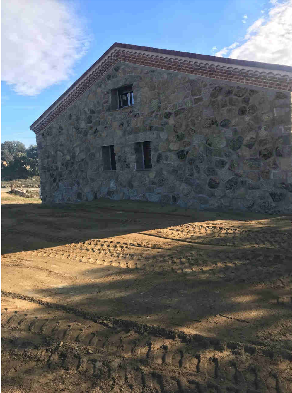
Fachada Norte de la edificación
