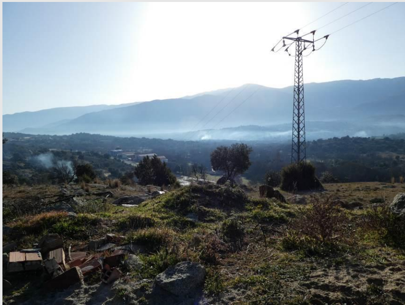
Fotografía 3. Apoyo n° 6621 desde el norte
