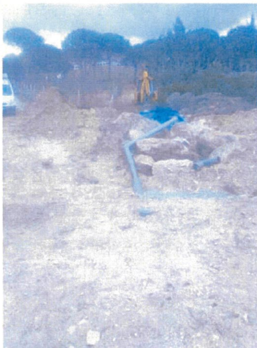
Conexión arqueta supervisión y decantador digestivo (Epurbloc)
