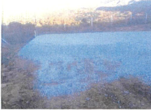
Colocación primera capa de grava
